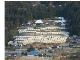
アンカー工全景
