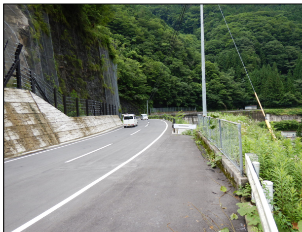
4 工区 供用状況
