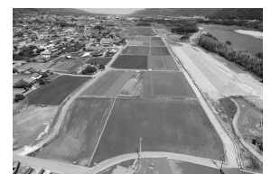
整備されたほ場
