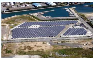
和田島太陽光発電所
