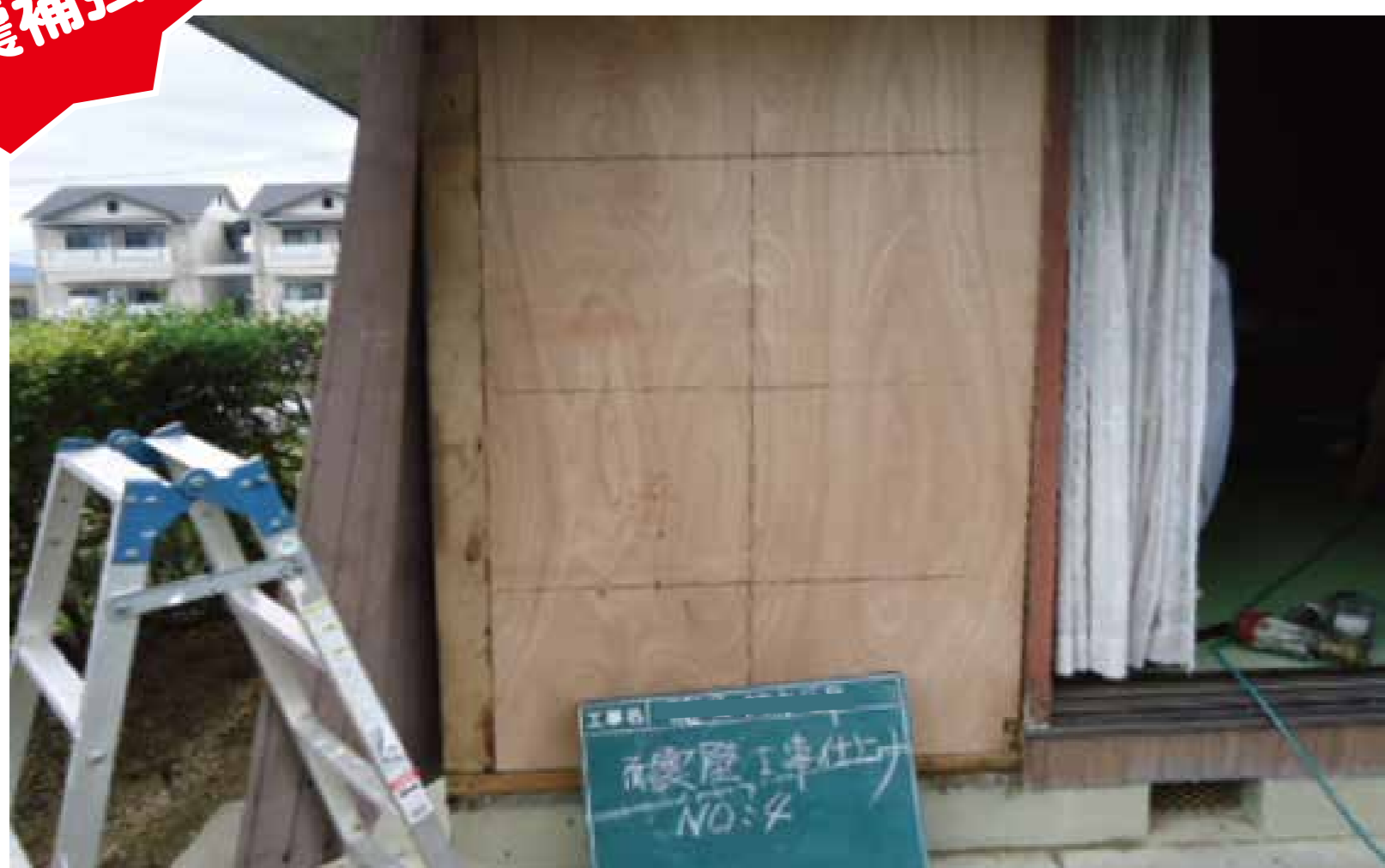
外部より耐震壁を設置
