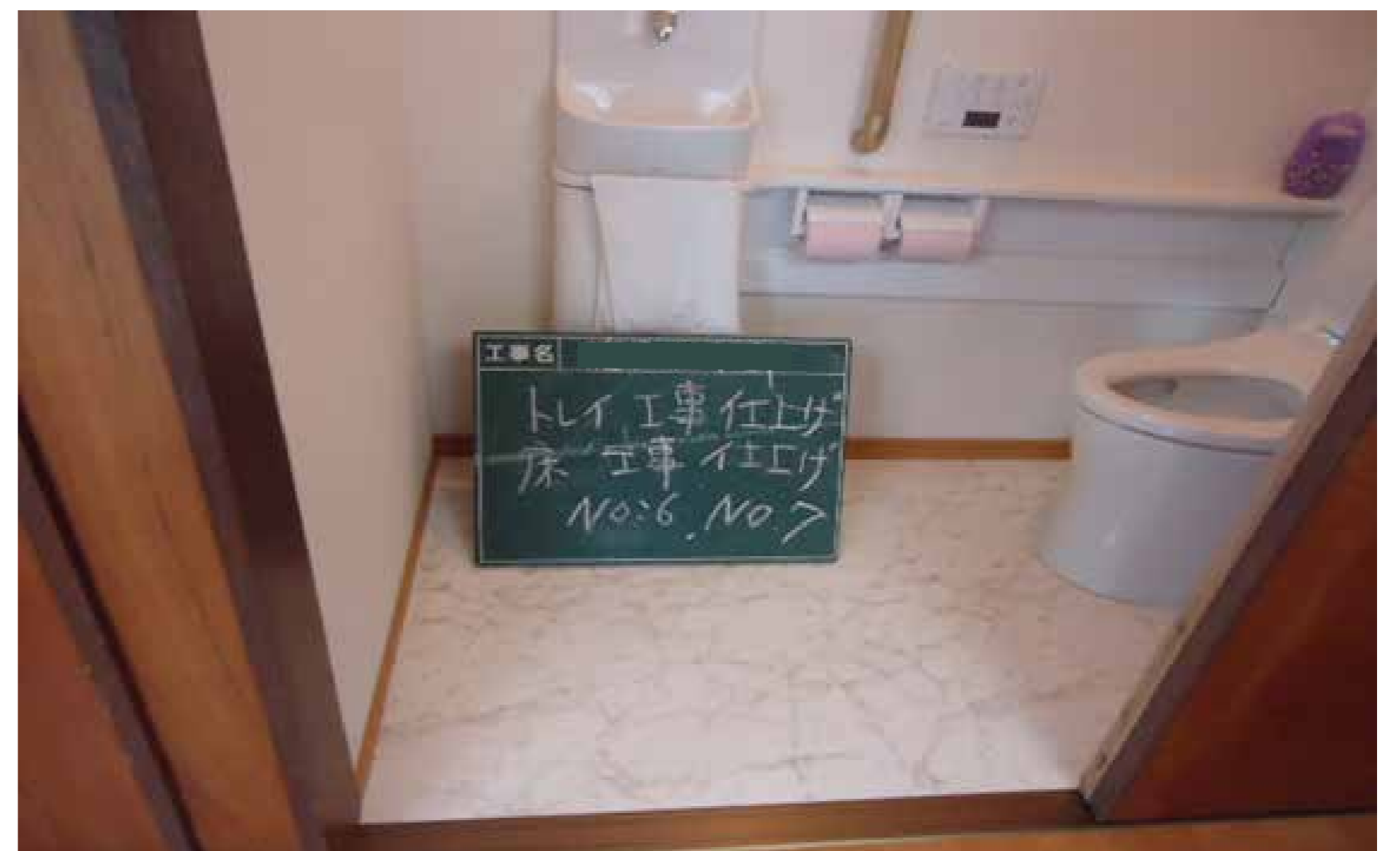
納戸から洋式トイレへ改修
