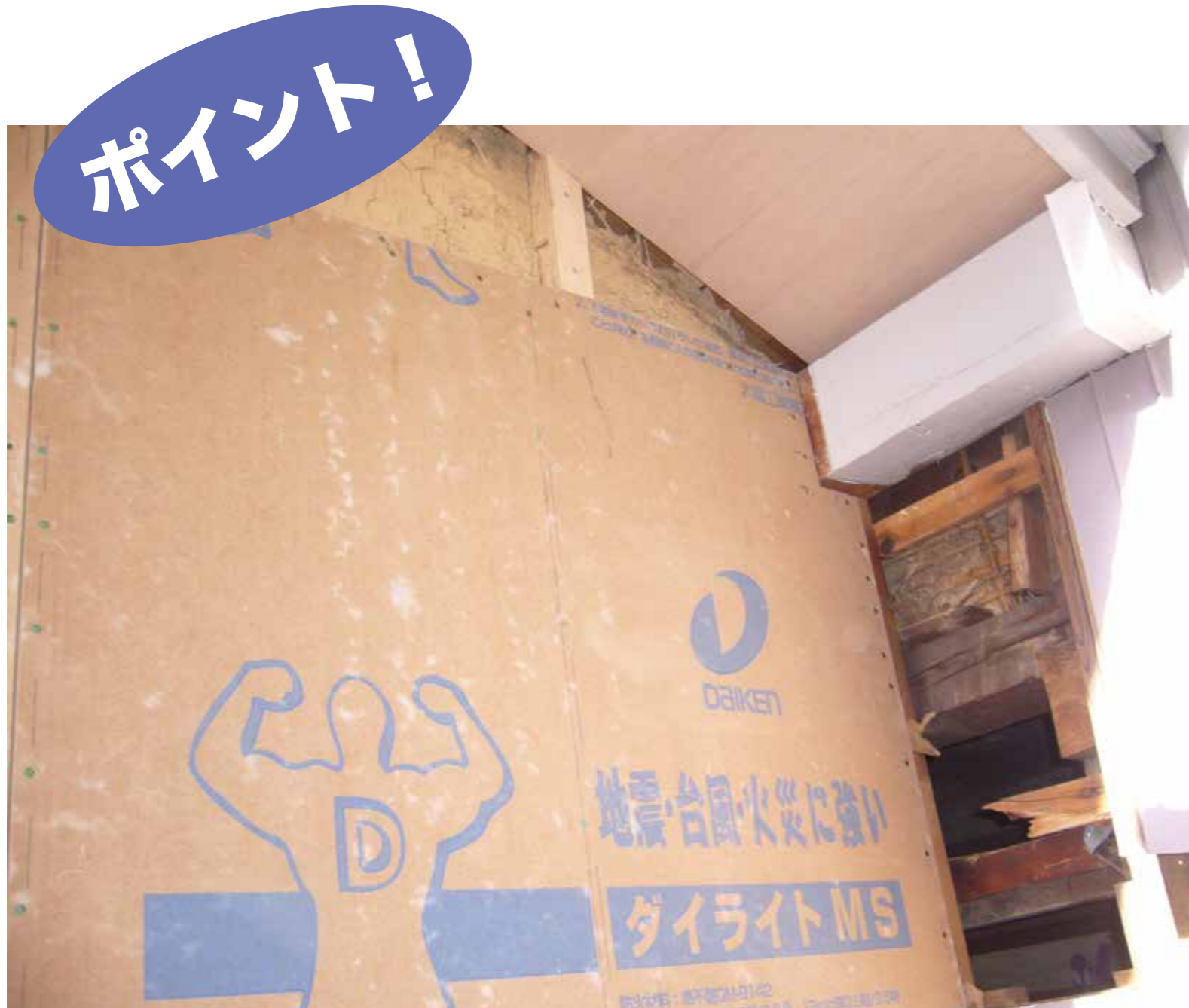
耐震壁補強工事
