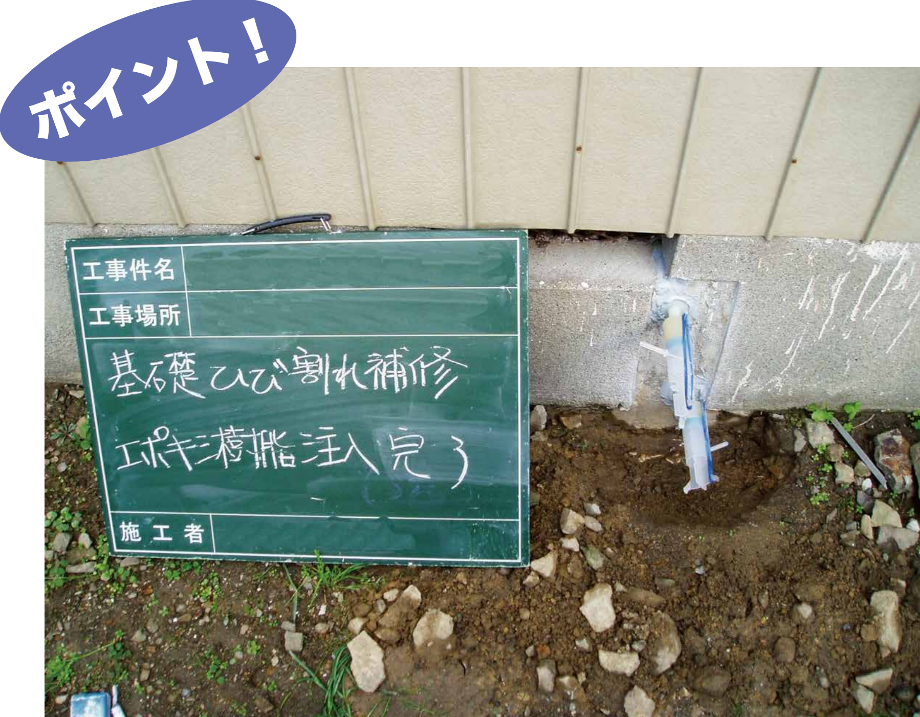
基礎ひび割れ補修 ひび割れ部へはエポキシ樹脂注入
