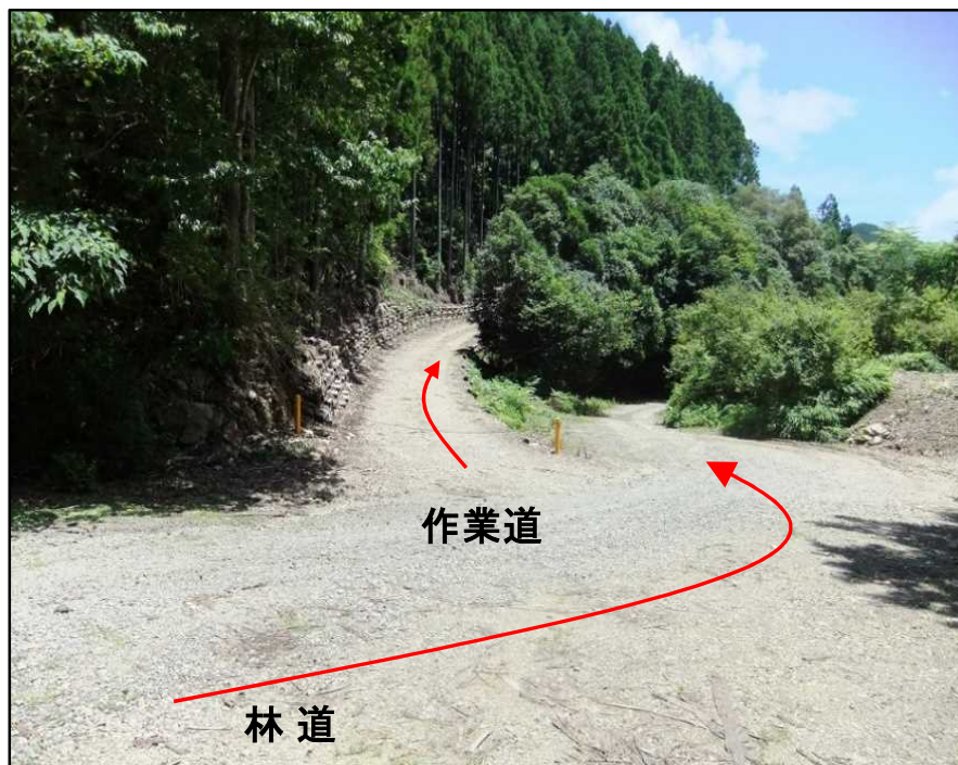
林道から分岐する作業道
