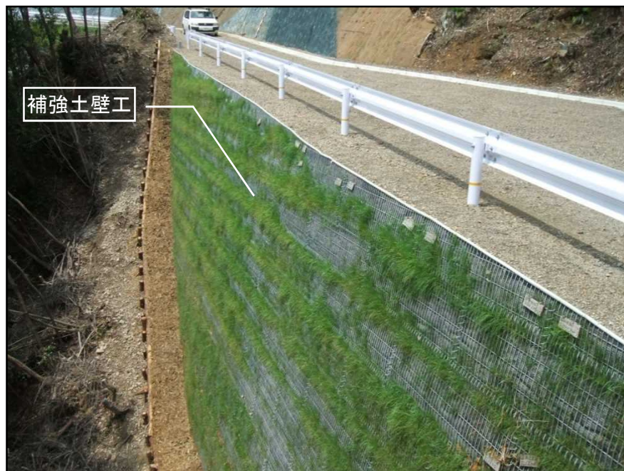
補強土壁工の施工
