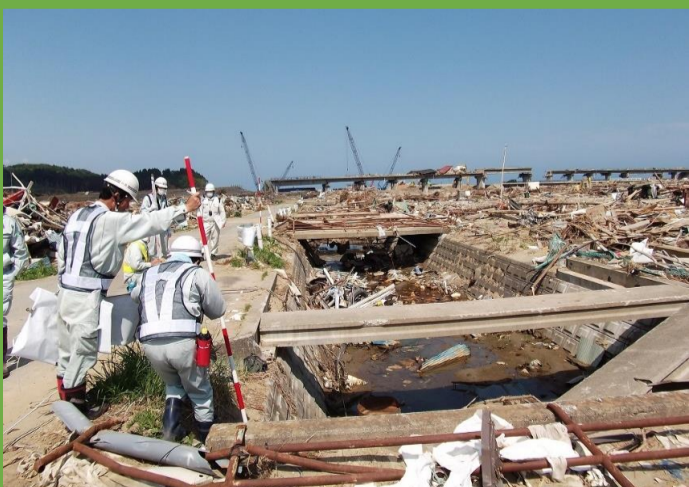
被災状況調査（葦野川）
