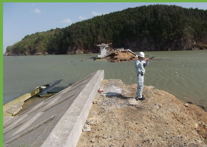
被災状況調査（津谷川）
