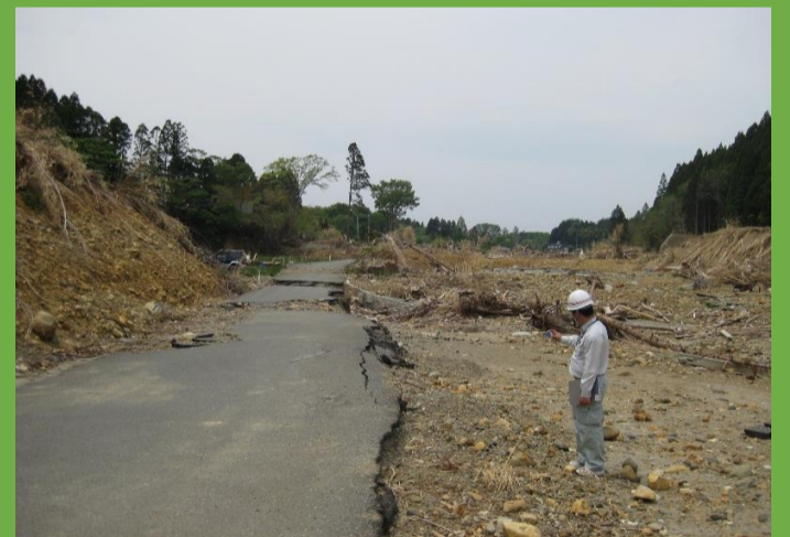
被災状況調査（市道）
