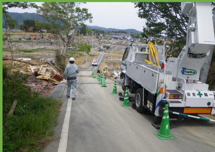
被災状況調査（市道）
