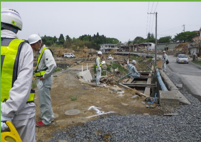
被災状況調査（市道）
