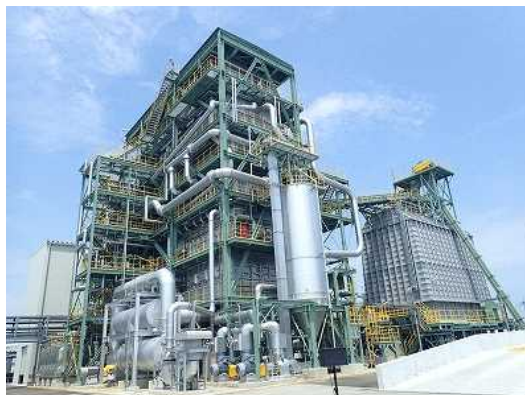
木質バイオマス発電施設
