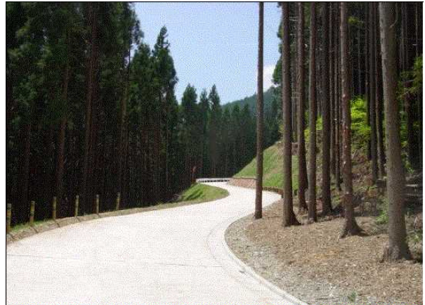
緊急輸送道路を補完する林道
