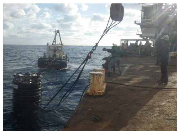
中層型浮魚礁の設置
