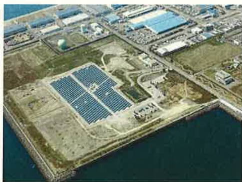
マリンピア沖洲太陽光発電所
