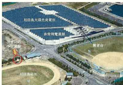
和田島太陽光発電所
