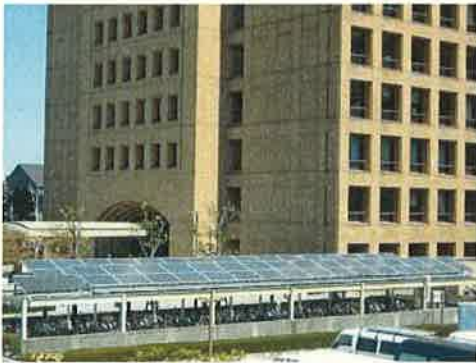
県庁舎太陽光発電パネル
