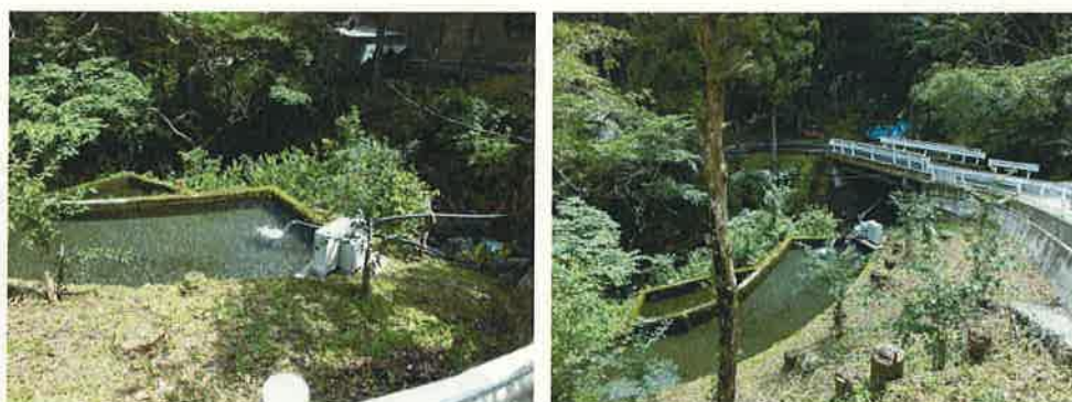
那賀川への小水力発電設置状況
