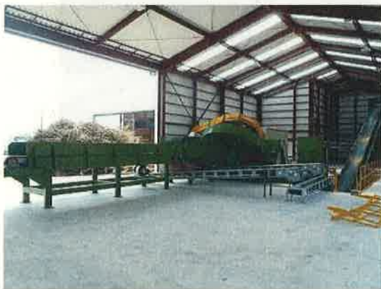
木質バイオマス燃料用加工場
