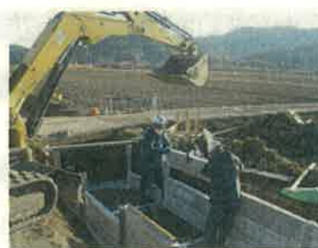
老朽化した水路の更新
