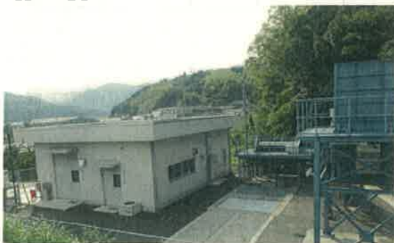
排水機場(阿南市)
