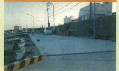
機能保全工事
