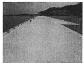
牟岐漁港 耐震強化岸壁
