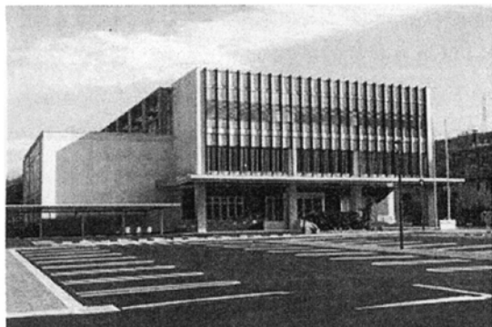
図1 徳島県立農林水産総合技術支援センター外観(徳島県名西郡石井町)
