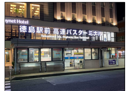
徳島駅前高速BTの改修
