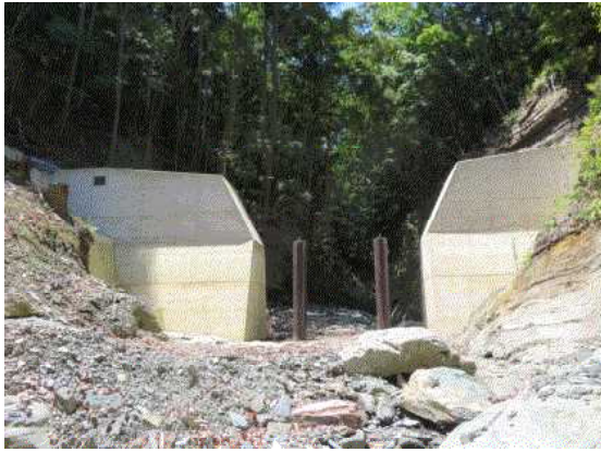
流木捕捉式治山ダム
