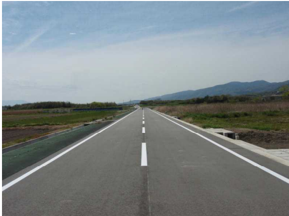
緊急輸送道路を補完する農道
