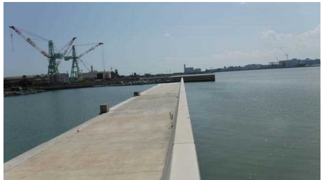
漁港整備（粟津漁港）
