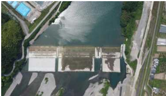
那賀川南岸堰（那賀川地区）
