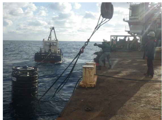
中層型浮魚礁の設置
