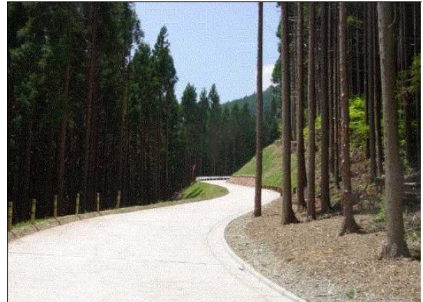
緊急輸送道路を補完する林道
