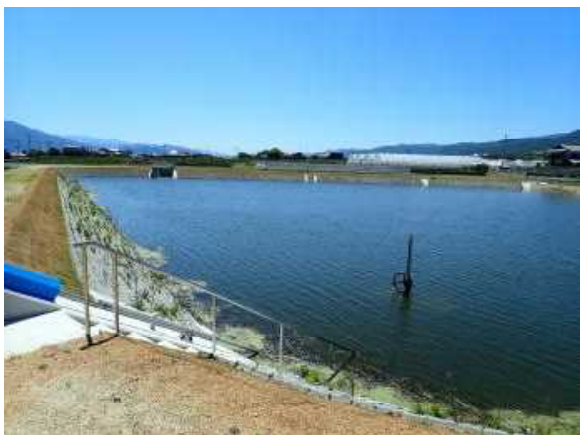
整備された農業用ため池
