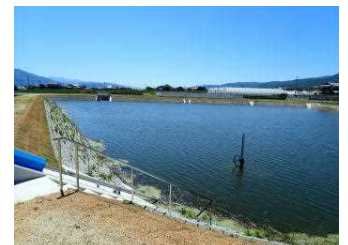
整備された 農業用ため池
