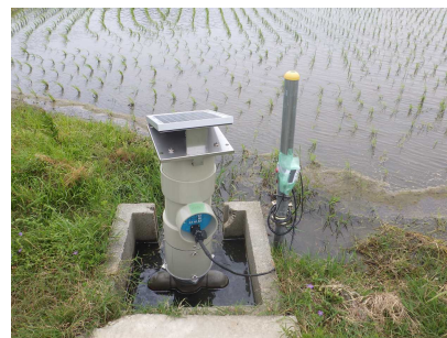
自動給水システム
