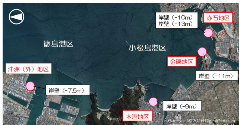
図 2.23 徳島小松島港クルーズ船寄港岸壁
