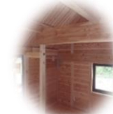
板倉構法 仮設住宅
