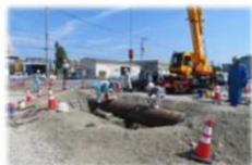
復旧訓練 (令和元年8月実施)
