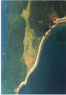
②護岸の状況
