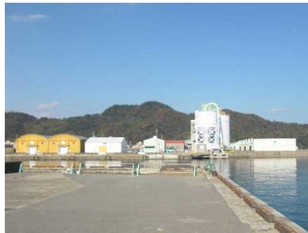
沿岸沿いに立地する工場や倉庫
