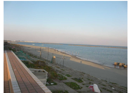
今切港海岸の緩傾斜護岸
