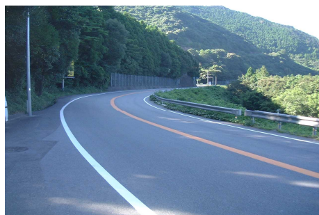
主要道路網である国道 55 号
