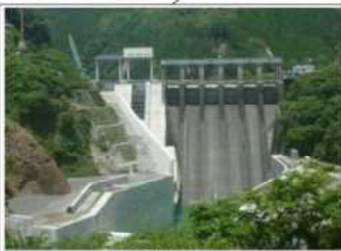
長安ダム改流事業 新設洪水吐ゲート 令和元年出水期より運用開始
