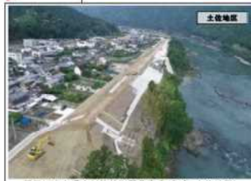
那賀川床上浸水対策特別緊急事業(和食・土佐地区) 河川堤防 令和2年度完成予定
