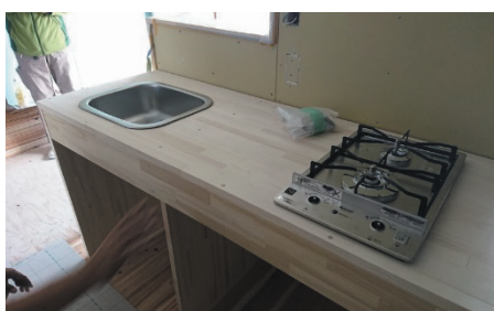
ホームセンターで購入できる集成材で作る木製キッチン
