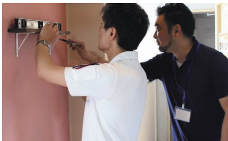
水平器を使って棚受けを取り付け
