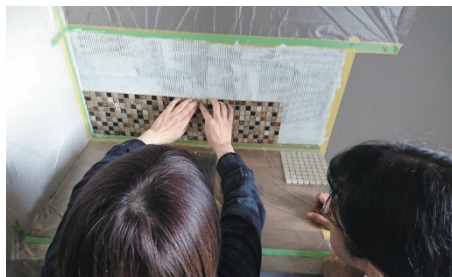
シート貼りのタイルなので施工しやすい
