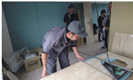
黙々と作業しながら、説明してくれる棟梁大工さん
