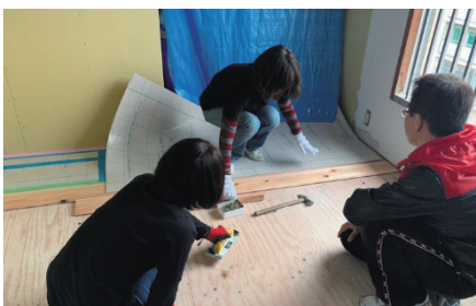
職人さんようにはいかない、進まない…床張り。
