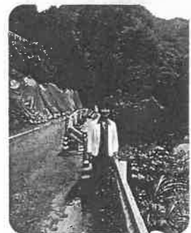
2018年8月15日 7月豪雨災害で被災した山城町白川谷視察 今も関係者の皆様が復旧作業に取り組んでくれています。
