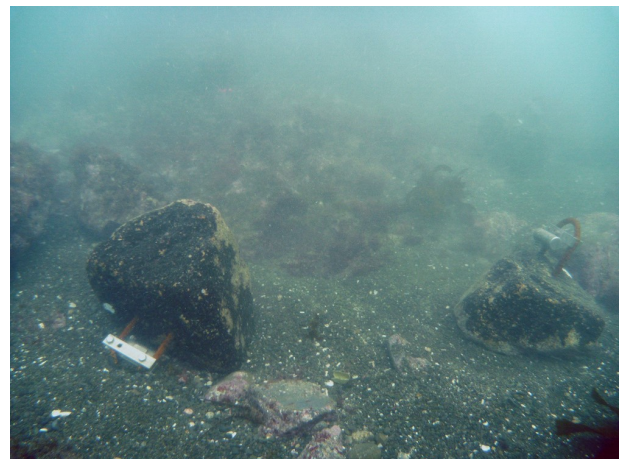
写真4. 台風通過後に転倒していた小型单体礁（平成30年8月）
