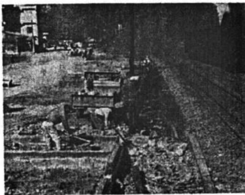
はじめた立体交差路の新設工事
