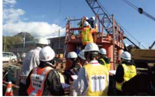
掘削機に登り、現場の安全を点検
