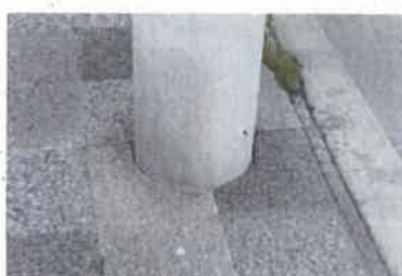
インターロッキング敷設
