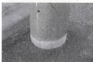
アスファルト処理
