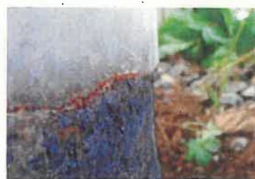
アスファルト部分を除去した状況（腐食が進んでいる）
