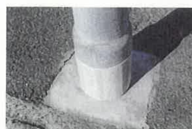
コンクリート処理
