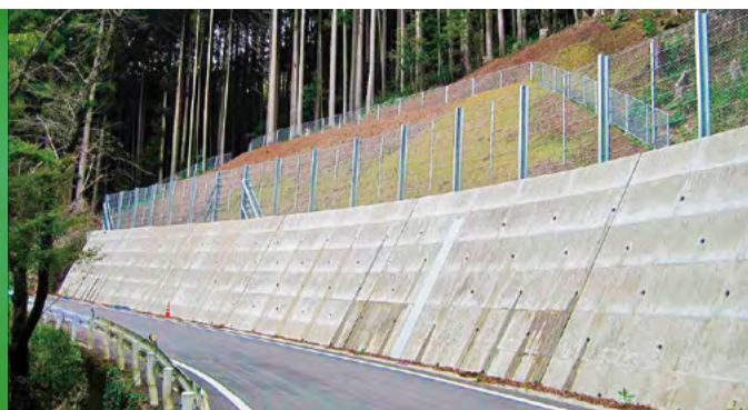
道路の法面对策工事などによる県土強靱化の加速
