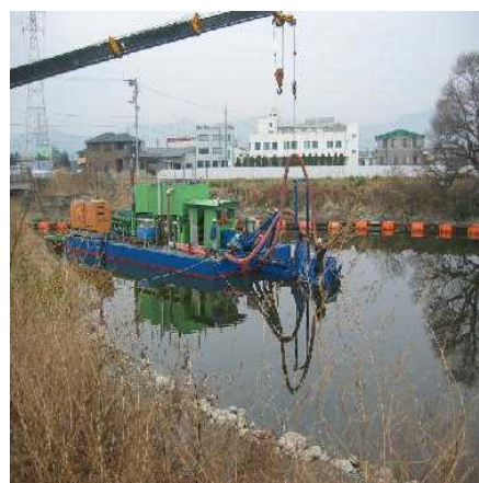
正法寺川の浚渫状況
