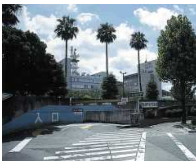
藍場町地下駐車場
