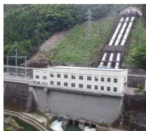
日野谷発電所
