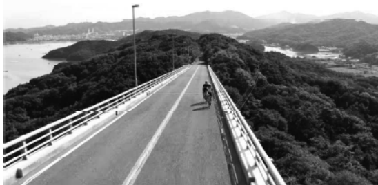
鳴門スカイライン（鳴門市）
