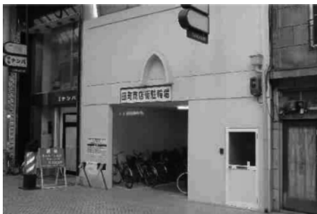
商店街の空き店舗を活用した駐輪場整備 (香川県高松市)
