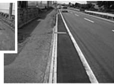
路側の改善（側溝の改修） （出典：愛媛県）
