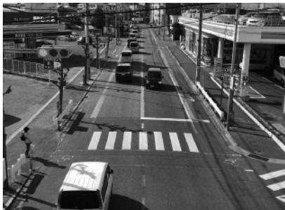
自転車専用通行帯（ブルーライン） （県道 徳島鳴門線 徳島市中吉野町）
