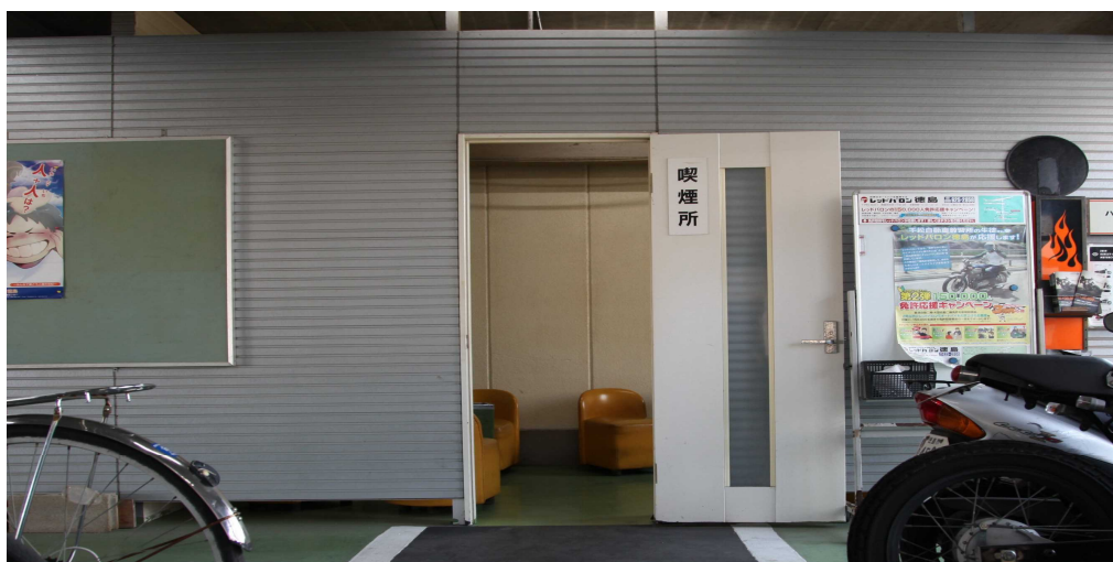
喫煙室を建物内から屋外の来客用駐輪場横へ移設。
