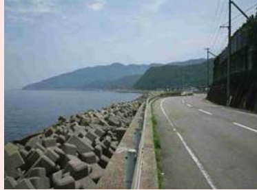
コンクリートブロックなどによる高波対策
