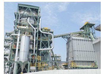
※クラボウ徳島バイオマス発電所
