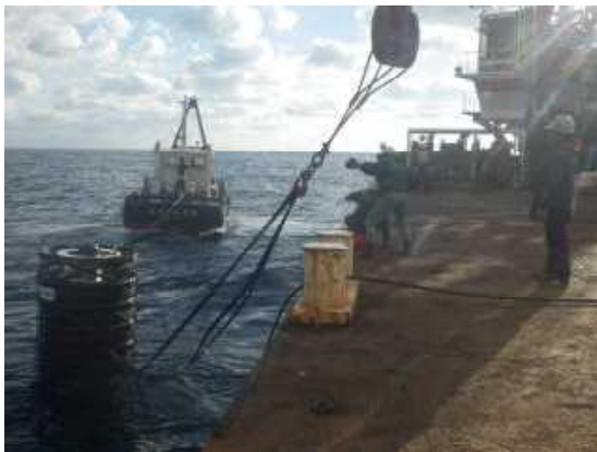
中層型浮魚礁*の設置
