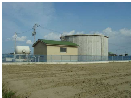
畑地かんがい施設（揚水機場）
