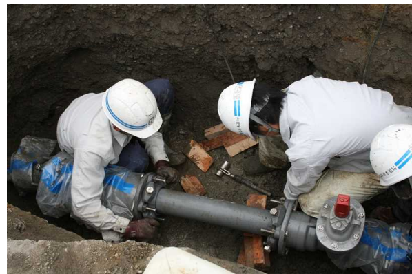
漏水修繕工事
