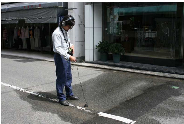
水道管の漏水調査
