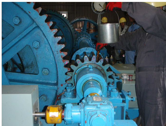
放流設備の点検状況(正木ダム)
