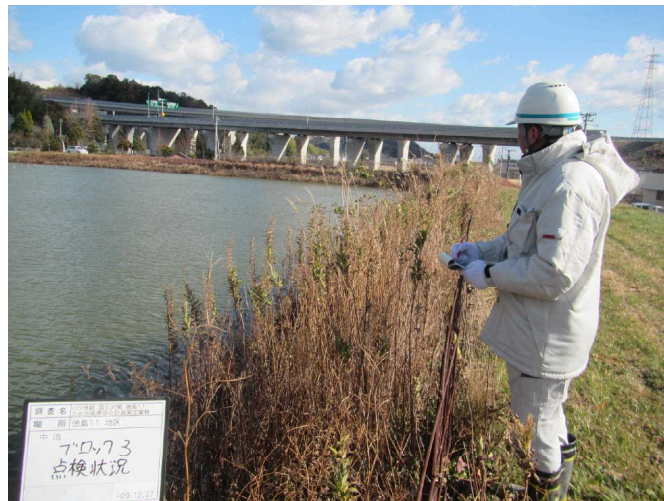
張石（ブロック）の損傷、抜け落ち箇所の点検
