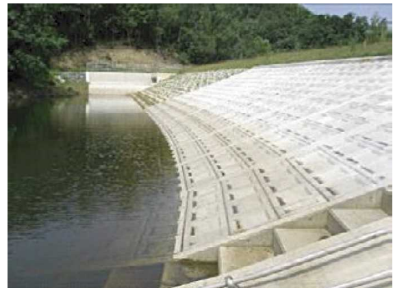
整備されたため池
