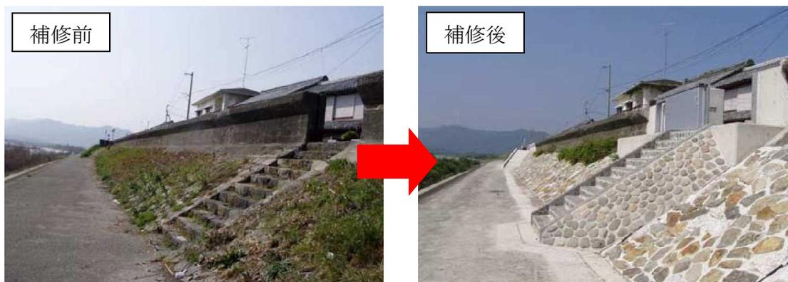
写真4-8 護岸の補修状況（那賀川）
