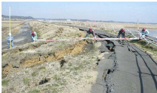
写真 4 - 1 0 堤体の液状化発生状況
