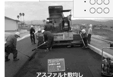
アスファルト敷均し
