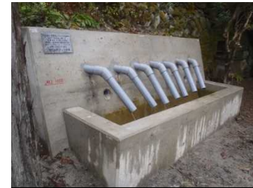
横ボーリング工 (Dブロック)
