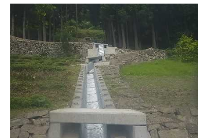
水路工 (Eブロック)
