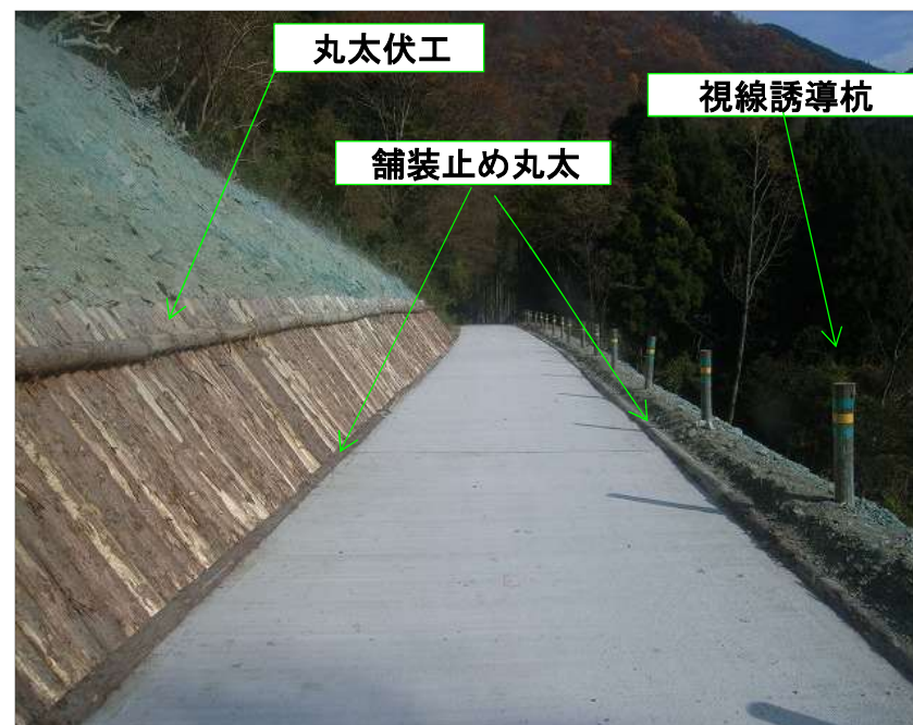
丸太伏工の施工状況
