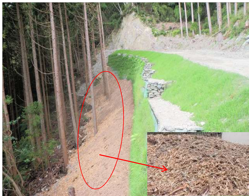
補強土壁工+根株チップの施工
