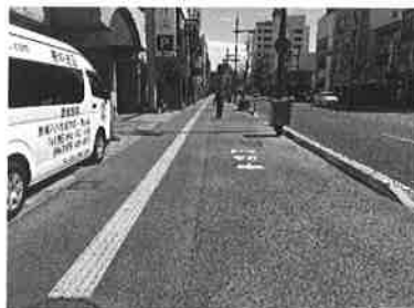
国道438号 (徳島市大工町)
