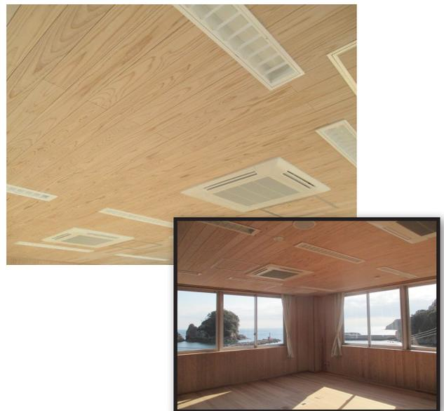
第11図 開発製品（準不燃材料「タフネン」）の施工例（徳島県立農林水産総合技術支援センター水産研究課庁舎）
