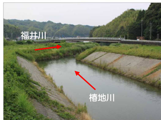
写真 1-4 樺地川・福井川合流点 (樺地川から福井川 2.3km 付近を望む)
