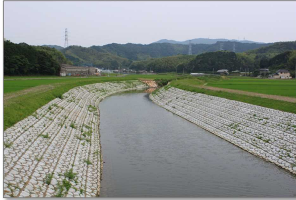
写真 4-1 榎地川改修後の状況
