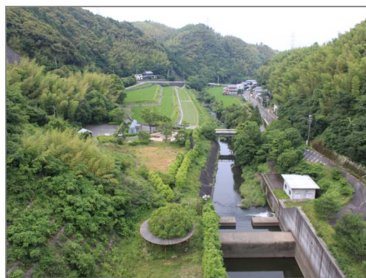
写真 2-11 福井ダム直下の状況
