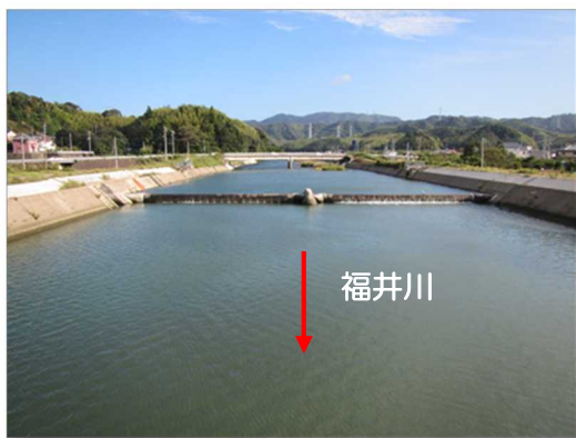
写真 1-3 福井川大原堰 (福井川河口から 1.8km 付近)
