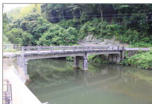
写真 2-9 補助測定点 (鉦打橋)
