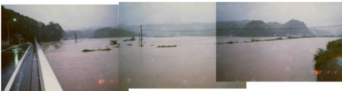
写真 2-1 昭和 63 年 6 月 24 日 椿地川合流部の被害状況 (河口から 2.3km 付近右岸)
