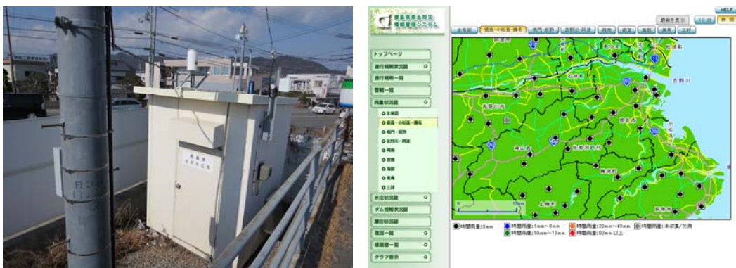
写真 4-1 水位観測施設（法花）およびインターネットによる情報公開状況
