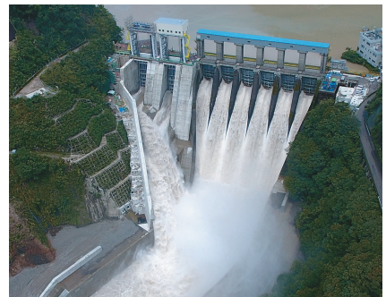
長安口ダム改造事業（放流ゲート増設）
