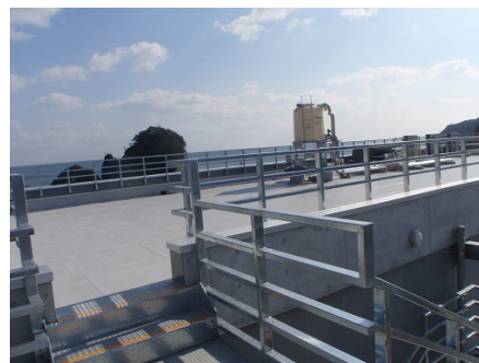
▲屋上は海拔18m(津波想定最大波高9m)の高さがあり、貯水タンクから飲み水を確保できます。
