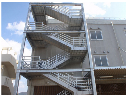
▲研究防災棟には発災時に屋上に避難するための階段が設置されています。キュービクル、自家発電装置、冷蔵庫は破砕時でも稼働できるように3階に設置されています。
