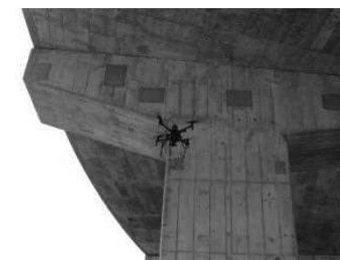
ドローンによる点検
