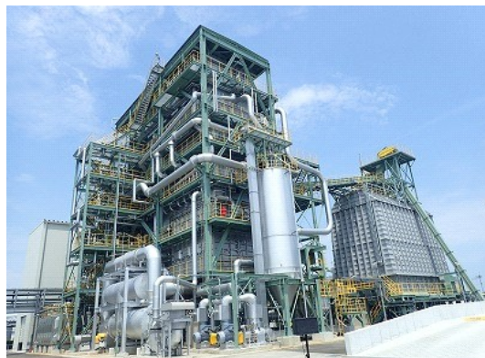
木質バイオマス発電施設
