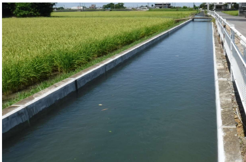
幹線水路（那賀川地区）
