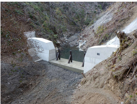
流木捕捉式治山ダム
