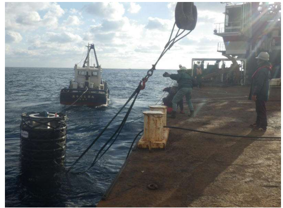
中層型浮魚礁の設置
