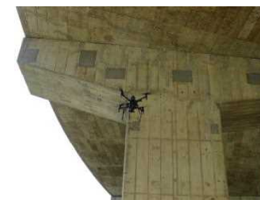
ドローンによる点検
